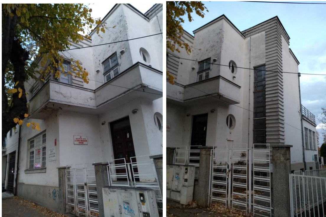
Slika 2. Fotografije postojećeg objekta
